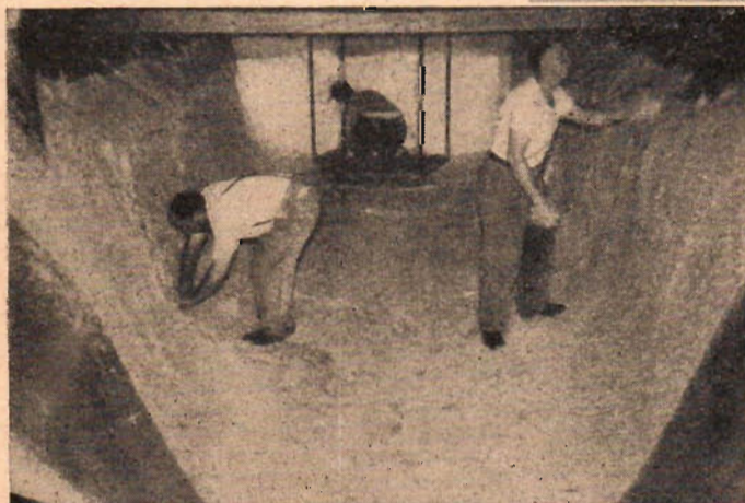
T. v. två bilder från tillverkningen av flottans 9 meter långa experimentbåtar. Glasfibermattorna placeras i formarna varefter de impregneras med en polyesterharts.
