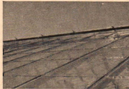
Vattenkylningen har startat. Resultat: ca 10° temperatursänkning på 5 minuter. Vattnet sprids genom munstycken på taknocken.
