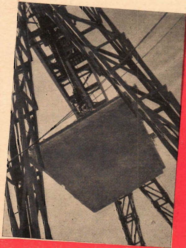
Ett bjälklag lyfts på plats av den kraftiga bockkranen — upp till 10 ton tar den, vilket motsvarar 18 m 2 golvyta i det nya snabbbyggda huset.
