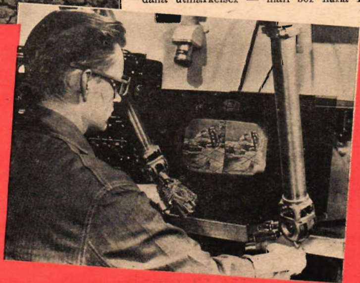
Ett farligt experiment i laboratoriet manövreras med tredimensionell television och fjärrstyrda instrument av teknikern.
