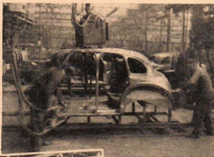
Varje plåt pressas med 20 tons tryck.
