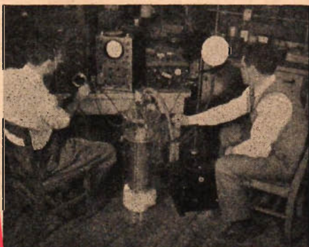
Bilderna i mittraden visar överst ett moment i studiet av en superledares termomagnetiska egenskaper. Forskaren vid bordet håller på att applicera ett magnetiskt fält kring superledaren. — På mellersta bilden tappas flytande helium från en s. k. Collins kryostat till mindre kärl. — Nederst håller man på att bestämma temperaturens beroende av djupet i en superledande koloid. Heliumbadets temperatur kontrolleras genom att variera trycket över kokande helium.
