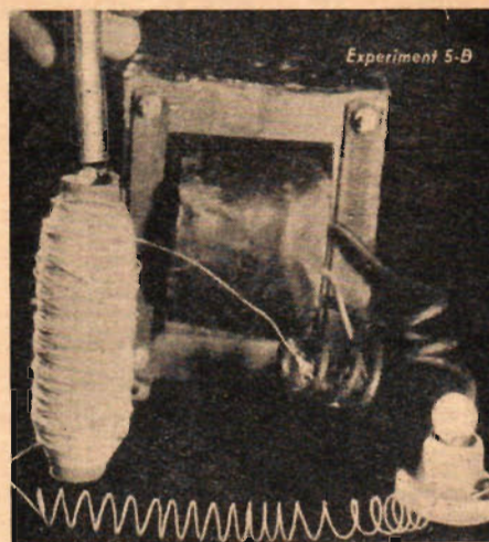
Lampan lyser på likström och järnstaven, som skjuts in i solenoiden, påverkar inte experimentet.
