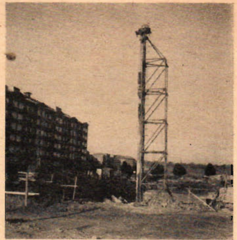
Den stora hejarkran som används vid Hagruppålningen i en grund i Stockholm.
