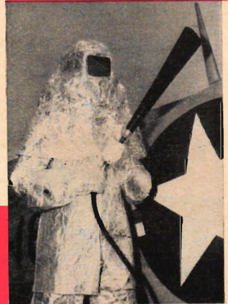
Tryckdräkt som tillåter flygare att uppehålla sig på höjder, som normalt skulle betyda ögonblicklig död.
