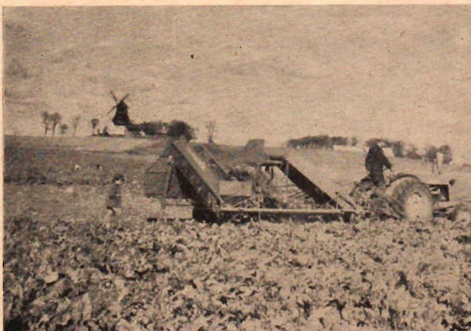
Betupptagningsmaskin modell SSA i arbete på den skånska slätten.
