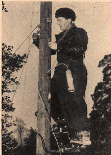
Den nya Primuslampan kan hängas i bältet under arbetet uppe i stolpen.
