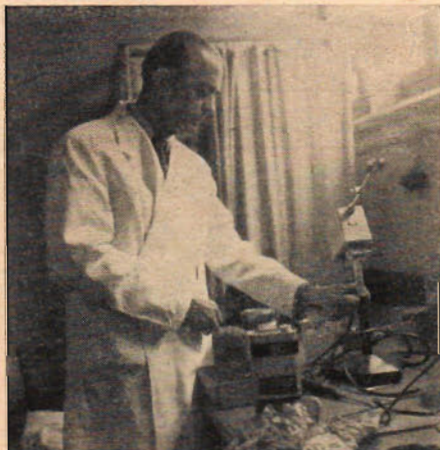
Dr Gustafsson demonstrerar en apparat för uppmätning av obalans i framhjul.
