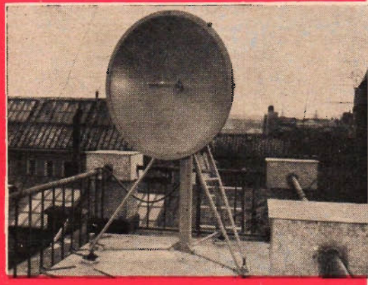
Överst t. v.: Televisionstekniker Bengt Johansson vid kontrollbordet i Tekniska högskolans nya lokaler. — Överst t. h.: Den komplicerade vatten- och luftkylningsanordningen för sändarenheten. — Nederst t. v.: Sändaren till radiolänken. — Nederst t. h.: Spegeln på Sandrew-ateljéernas tak, den första i Sverige för televisionsöverföring.
