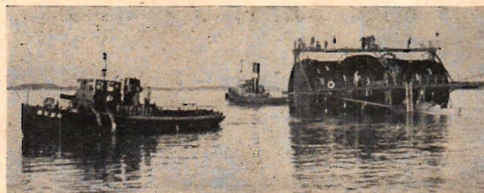
T. h. en bild från utläggningen av undervattensledningen i Gullmarsfjorden.
