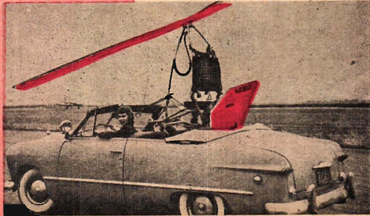
T. h.: Glidaren kan med lätthet placeras i bogserbilen och transporteras till en lämplig plats för flygningarna.
