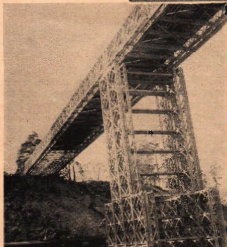
Av Bailey-materiel byggd balkbro på två pelare.
