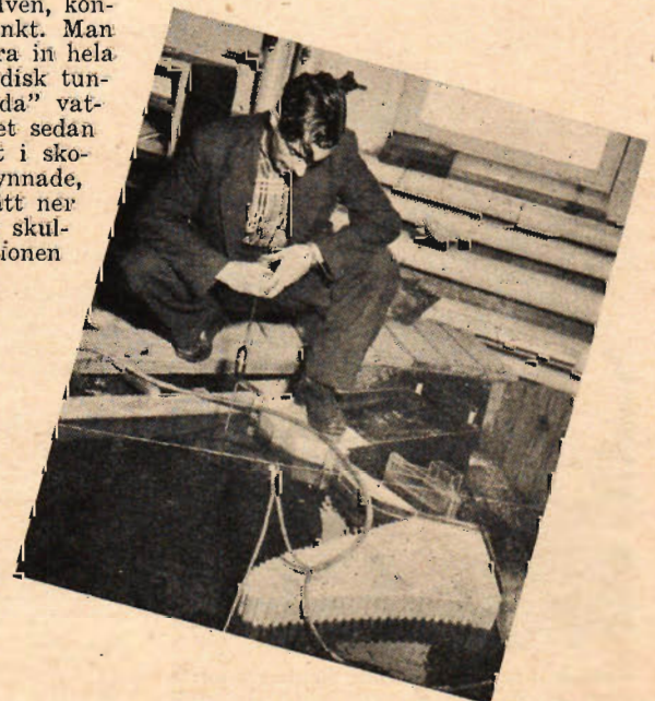
T. v.: Tekniker Rolf Lundmark och ingenjör Erik Persson under försök med en modell av den blivande dammanläggningen i Umluspen. Det är ett flottningsutskov som är föremål för in-tresset.
