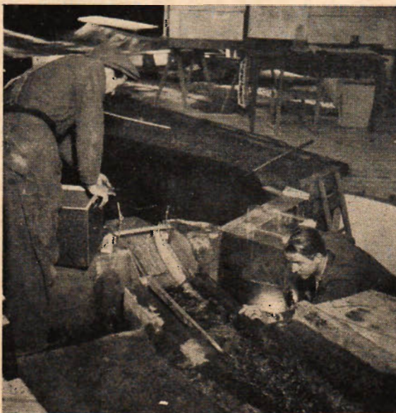
T. v.: Tekniker Rolf Lundmark och ingenjör Erik Persson under försök med en modell av den blivande dammanläggningen i Umluspen. Det är ett flottningsutskov som är föremål för in-tresset.
