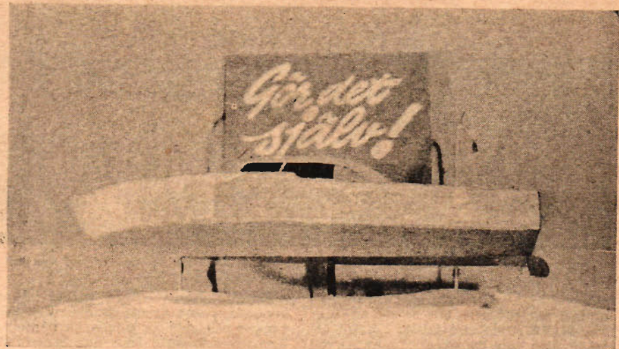
En modell av en båt under plastbehandling. Först har skrovet grundats med V-plast, därefter har från aktern lagts ett lager glasfiberväv (det mörkare partiet på modellen) och när hela skrovet överdragits med glasfiberväven anbringas över denna ännu en omgång plast. Till sist slipas ytan.
