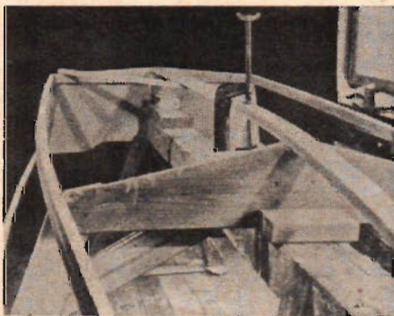
Fig. 5. Kölsvinet är uppallat med fräcklossar så att det ligger vågrätt mellan hjälpspananten och akterspegeln, som riktats i vinkel med en snedsträva.
