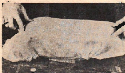
Fig. 2. Formen bestryks med plastharts. Därefter bekläms den med glasfiber som dräcks in i plastharts tills den blir genomskinlig.
