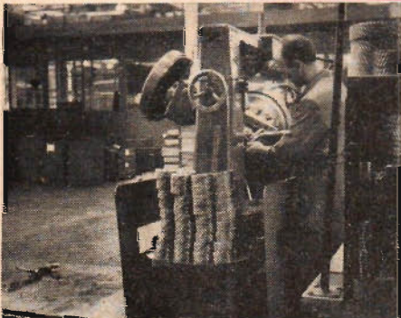
Kurt Thorberg, som här kollar ett mått i sin kuggfräsmaskin, står som synes litet ensam. Men snart fylls det tomma utrymmet ut av andra maskiner.
