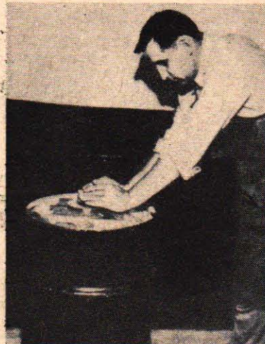
Fig. 1. Ett lämpligt "arbetsbord" för slipningen är ett bensin- eller oljefat.
