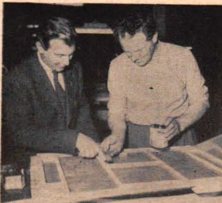
Kursledaren ingenjör Rolf Andersson, KSAK, inspekterar impregneringen av kroppspant nr 1 (som ska sitta närmast planet motor). Bilelektriker Artur Andersson från Landskrona flygklubb för penseln.
