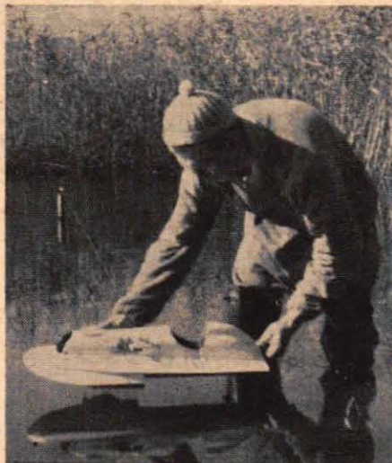
Polisassistent Erik Grönqvist är en av landets mest kända båtmodellbyggare. Han anser att modellbygget i sin helhet har stor funktion att fylla i vårt jäktade samhälle av i dag. På bilden ovan demonstrerar Grönqvist sin linkontrollerade speedbåt Z 101. Modellen är 65 cm lång, byggd av lind och försedd med en 5 cc glödstiftsmotor. Båten gör ca 40 km/tim. Bilden t. h.: Den 65 cm långa skalamodellen av vaxholmsbåten Nämndö är tillverkad av trä och försedd med ängmaskin. Passagerare och sjömän är snidade i trä.
