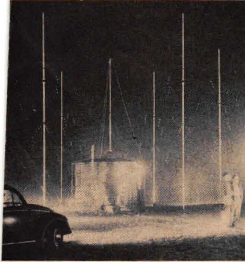
Telefunkens nya automatiska radiopejlanläggning utanför Ulm i Sydtysskland bevakar satelliterna dag och natt. Man har här ett Adcock-antennsystem med sex master vid en antennbas av 12 m.
