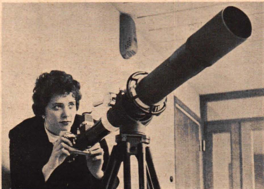
Canons största teleobjektiv är en imponerande presskanon med hela 800 mm brännvidd. Ljusstyrkan är f:8, vilket är tillräckligt för att t. ex. ta bilder av månen. Detta japantillverkade objektivet kostar 3 410 kr.
