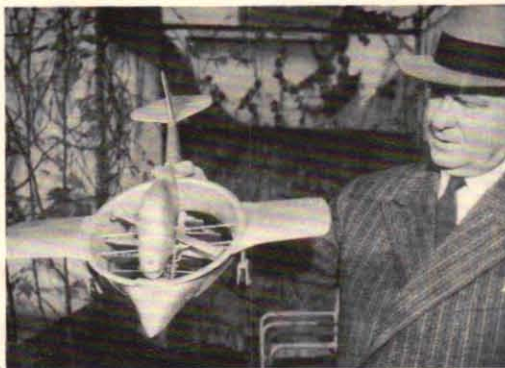
Den italienske ingenjören Ettore Ricci har nu konstruerat två nya vertikaltstartplan i modell. På bilden t. v. visas han modellen av R-15, ett readrivit plan som skulle få en maxfart av 300 km/tim och en stighastighet av fem m/sek. T. h. visas R-16, som är ett propellerdrivet vertikaltstartplan. Ricci anser att detta plan bör uppnå en hastighet av ca 350 km/tim med två 270 hästars Lycoming-motorer.
