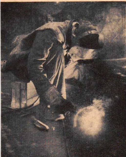
Svetsarna har varit i livlig verksamhet vid det stora kraftverksbygget. Här svetsas en reservcistern. Kraftverket kommer att i första rummet leverera varmvatten till Hässelby och Vällingby.
