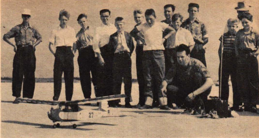
Modellflygaren Per-Axel Eliasson står här klar för start vid SM på Halmjön. Planet är en Skyscooter, som finns i byggsats från Veron. Modellen har 1,5 cc-motor och är försedd med enkanalsutrustning.
