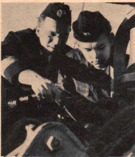
Ett modern lastfartyg har ett omfattande däcksmaskineri. Ett befäl måste känna till hur alla vinschar och spel fungerar, och här får en fartygsbefälselev en lektion vid en av vinscharna.
