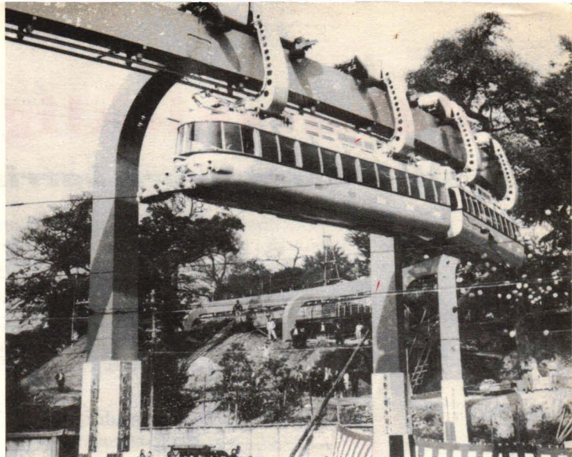
Japans första hängande tåg har nyligen premiärkört i Tokios zoologiska trädgård. Det silverfärgade tågsättet hänger i hjulförsedda bågar. Hjulen löper på ovensidan av en mycket kraftig balk. Det märkliga tåget trafikerar en 450 m lång bansträcka och hänger ungefär nio meter över marken. Varje vagn kan ta 31 passagerare. En liknande anläggning finns i Sydtyskland.
