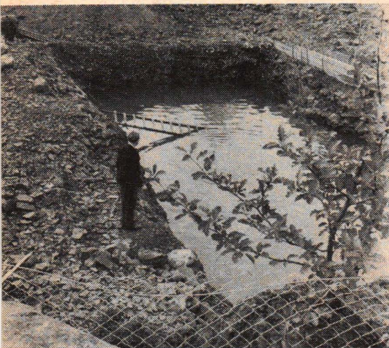
De djupa provborrningsgroparna är nu vattenfyllda. Här ses ett av de många provborrningshål, som tagits upp vid Stenstorp i Häggums socken.
