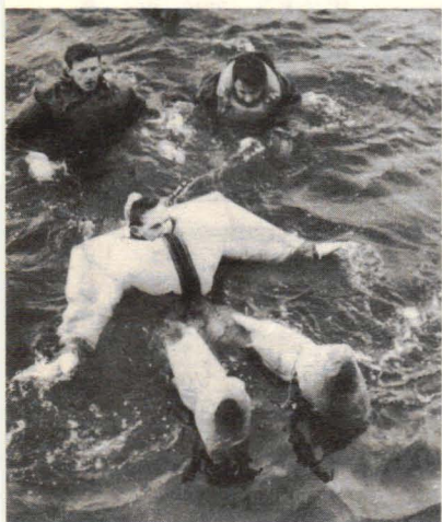
En ny livräddningsdräkt har provats i England. Den är uppblåsbar och håller bäraren flytande och ger den skeppsbrutne ett pålitligt skydd mot det iskalla havsvattnet vintertid.
