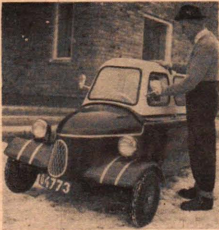
Gunnar Högglund har byggt en liten minibil som har en 7,5 hk motor och individuell fjädring på samtliga hjul. Karossen är gjord av lättmetall.
