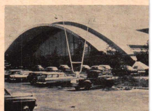
Entrén till New Yorks internationella flygplats skyddas av en valvbåge av rostfritt stål. Bågens spännvidd är 63 m, bredden 32 m och höjden 14 m. Aven ankomsthallens tak täcks med rostfritt stål.
