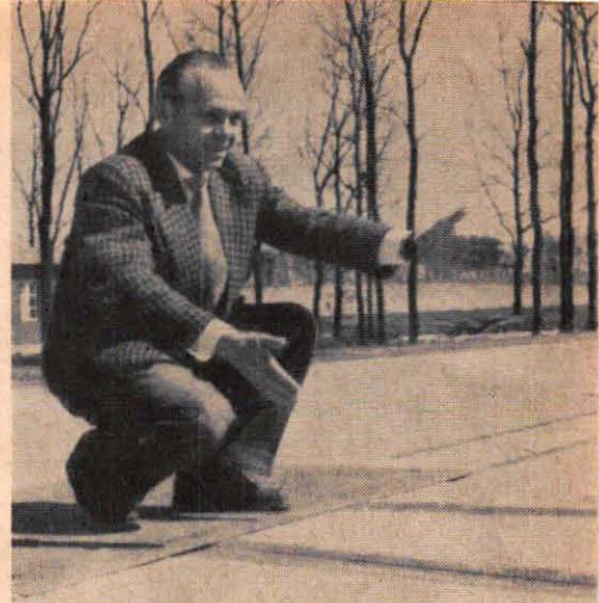
Teknik för Allas utsände tillhörde den första grupp journalister i världen som fick tillträde till Volkswagenwerks delvis unika provbana. Ovan demonstrerar dr Karl Peter, en av de fyra betongkilar, som ersätter fogar på hastighetsbanan.
