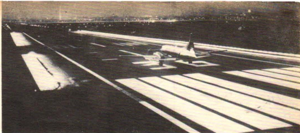
Ett flygplan landar här på flygfältet i Washington. Denna bana för instrument- och nattlandningar är kraftigt upplyst av två 420 m långa ljusrampor med tillsammans 272 mycket starka lampor.
