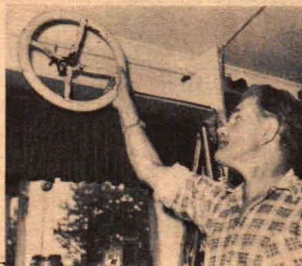
En amerikansk tvåvåningsantenn på 26 meter klarar utlandsförbindelserna till Wallstedts TV-apparat. Med en gammal Ford-ratt ställer han in sin antenn, som gått på ca 300 kr, i önskad riktning.
