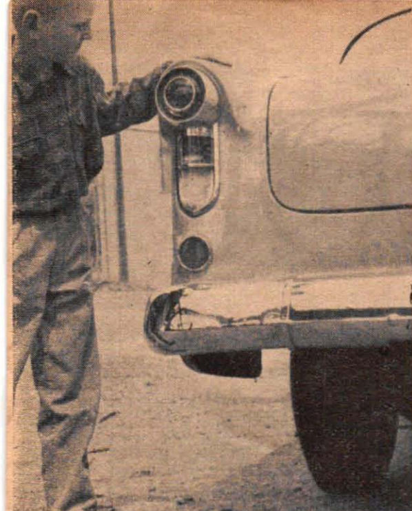
Bakljusarrangemanget på nya Kapitän har fått svälla ut en hel del, jämfört med tidigare modell. Överst bakljus, därunder bromsljus och blinkers.
