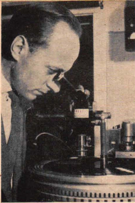
En forskare betraktar ljudspåren i den nya stereofoniska grammofonskivan med hjälp av ett specialmikroskop. Här har två ljudkanaler från två olika mikrofoner registrerats i ett enda spår.
