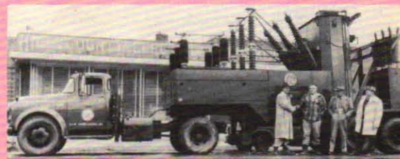
General Electric har byggt en rullande transformator som väger 16 ton och är 7,5 m lång. Den skall användas för att upprätthålla driften när den ordinarie transformatorn måste tas ur bruk.
