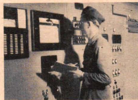
På kontrolltavlan registreras bl. a. temperaturen såväl på inkommande som utgående ärtor och genom att bara trycka på en knapp kan man här ta reda på temperaturen i bandfrysanläggningen.
