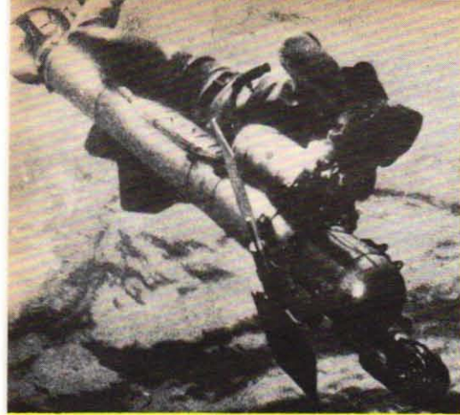
En "undervattensskoter" tillhörde slagnumren på en fransk marinutställning nyligen. Farkosten har en maxfart av tre knop under vatten, är elektriskt driven och kan på mycket kort tid föra en gradman ned till 70 meters djup och sedan upp igen.
