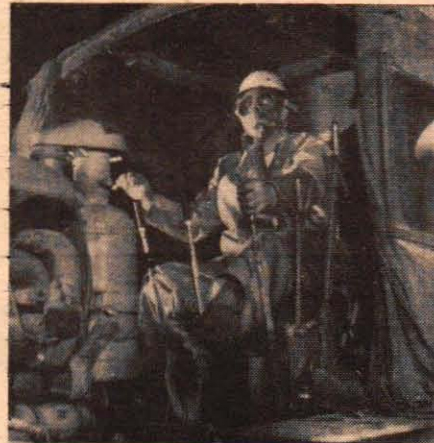
Så snart en sprängning var klar, "erövrades" det nya tunnelpartiet av gasmaskförsedda truckförare. När tunnelns takparti sprängdes, ökade tunnelns längd med 7 meter för varje sprängning.
