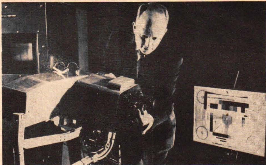
En tvåögd TV-kamera ser för att åskådaren verkligen får samma känsla av djup i TV-bilden, som vi får med våra egna ögon. I verkligheten ser man på TV-duken två bilder, som avlöser varandra snabbare än det mänskliga ögat hinner upptakta. Här justeras de bögge kamerainserna före en tagning.
