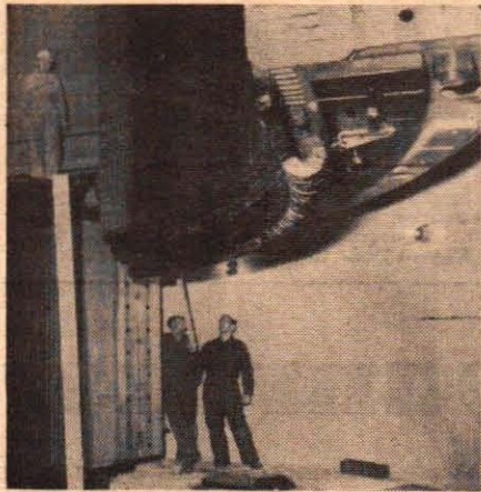
De ASEA-byggda generatorerna till Stornorrfors är av imponerande dimensioner och måste fraktas i sektioner. Här monteras en del av en stator in på sin plats i kraftverkets maskinsal.
