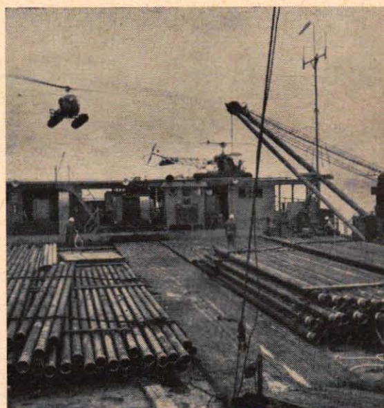
9 En helikopter landar på borrpråmen i Maracaibobukten med förnödenheter från basen i land. På däck ligger massor med borrhör, som det inte får råda någon brist på. Ofta behöver man ju borra kilometervis ner i havsbotten.
