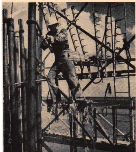
7 Erfarenhet, snabbhet, styrka och goda nerver krävs av den man som arbetar i tornet på borrplattformen "Mr Gus". Han hanterar de tunga femtums rör av vilka man sammanfogar borrhängningen och befinner sig 37 m över plattformens däck.
