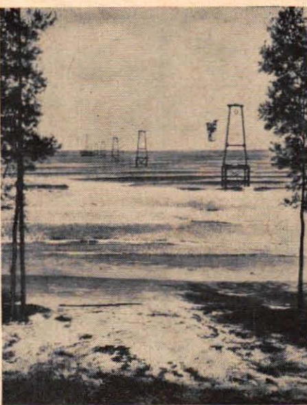
8 Med linbana klaras kommunikationerna med land från en permanent borrplattform utanför Brittiska Borneos kust i södra Kinesiska sjön. Från plattformen, som är byggd för en belastning på 200 ton, kan fyra hål borraras — s. k. riktad borrning.
