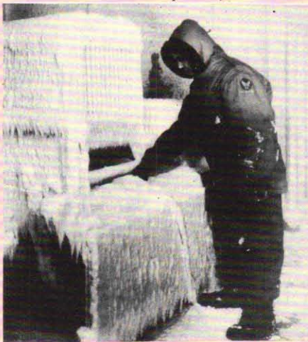
Av denna bild framgår hur en traktor tar sig ut vid minus 100 grader C. Den är nedfryst i amerikanska arméns köldkammare i Fort Monmouth, där forskarna provar ut material för polarkyla.
