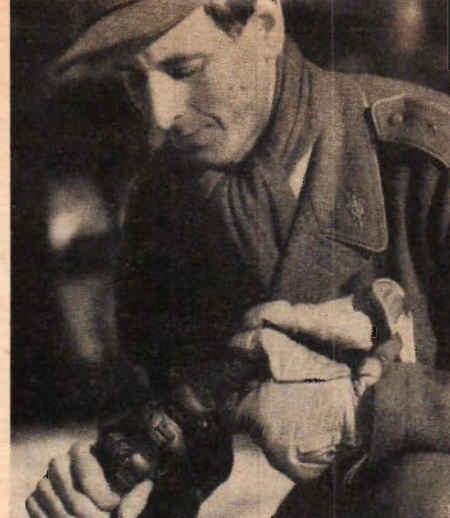
Höpkoppling av en del av den perforerade tryckluftslang, som efter sprängning av isen läggs ned på sjöns botten för att hålla vaken isfri.
