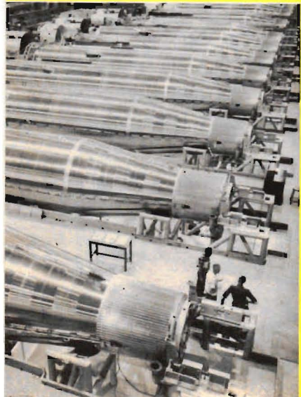
De amerikanska Atlas-robotarna serietillverkas nu vid Convairs stora fabriksanläggningar i San Diego i USA. Robotarnas kroppar är tillverkade av rostfritt stål. Här monteras jätterobotarna, som är ca 23 m långa och mäter 3 m i diameter. Överst t. v. på bilden monteras raketmotorerna. Atlas har en huvudmotor och två startraketaggregat.
