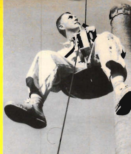
Den gamla hederliga "båtsmansstolen" har nu blivit motoriserad. Bilden visar den amerikanska Sky Climber, som fungerar som ett slags hiss i miniatyr. Stolen väger bara 15 kg, manövreras av den åkande och drivs med elström eller tryckluft.
