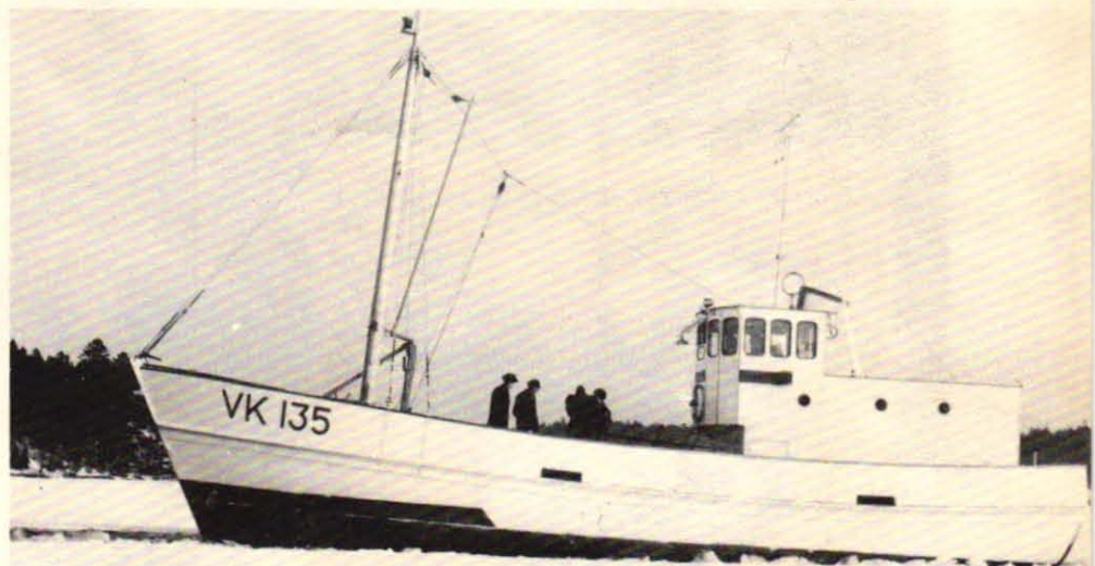
Fisksätra varv har nyligen levererat två tråtare, som byggts efter helt nya principer. Spant och köl är lamell-limmade och två Volvo-Penta marindieslar på vardera 125 hk driver den gemensamma propelleraxeln med hjälp av kilremmar.
