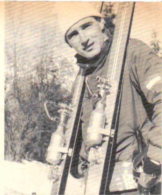
Den österrikiska firman Anton Kaestle lanserar nu en skidtyp med tryckluftbehållare. Komprimerad luft kan under högt tryck pressas in i skärnan på skidans undersida och bidrar därvid avsevärt till att minska skidans friktion mot snön.
