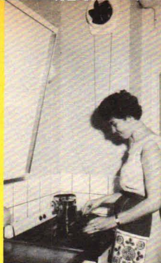
En ny köksfläkt har introducerats av AB Bahco i Stockholm. Den är försedd med metallkapslad motor på 40 W och har inbyggd strömbrytare. Den tystgående fläkten kan placeras i taket. Spjället ger viss ventilation även då fläkten inte körs.
