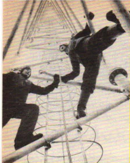
TV-masten i Hörby blir Europas högsta byggnadsverk: 320 m mot Eiffeltornets 300. Arne Gustavsson och Kiko Lethonen från Stockholm sisslar med det halsbrytande jobbet att foga ihop triangelsektionerna. I toppen är masten bara 240 cm bred.
