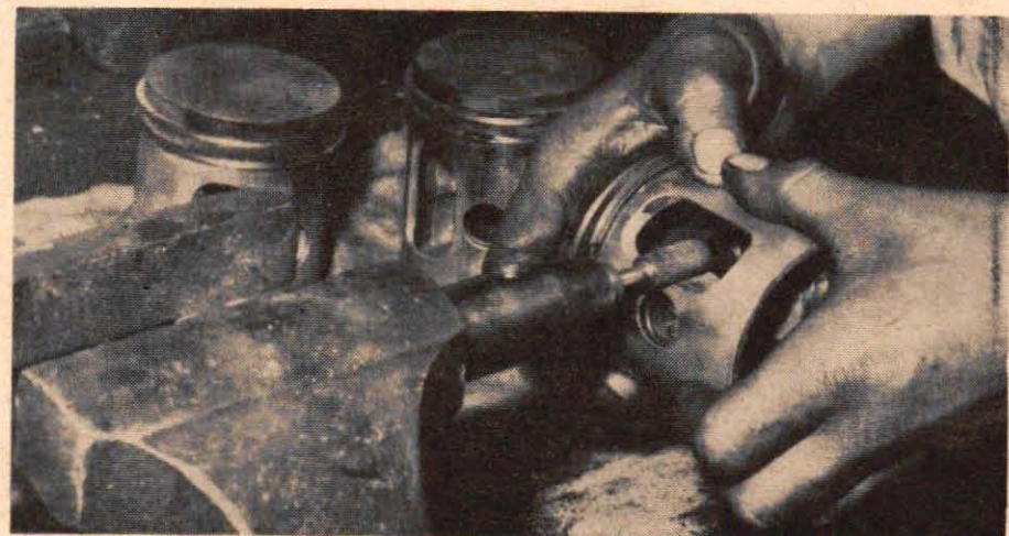
Upprättning och finputsning av kolportarna hör naturligtvis till de elementära arbetsmomenten i denna tvåtaktstrimmings högberg. Observera att kolvarna endast har två ringar mot ordinarie tre.
