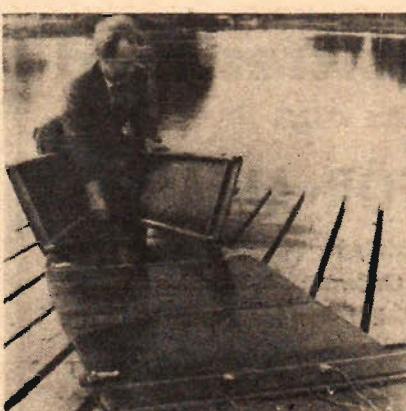
Sammansättningen börjar med att båtens botten "vecklas ut" t. v. Bottenplattan består nämligen av fyra segment plus akterspegel med tillhörande taft, och alla delarna är sammanfogade med gångjärn. Övan t. v. monteras fören på bottenstycket och t. h. ovan kompletteras bygget med första sidostycket. Sidostyckena dras fast med snabbblås, och alla skarvar tätas automatiskt med svampgummilister.
