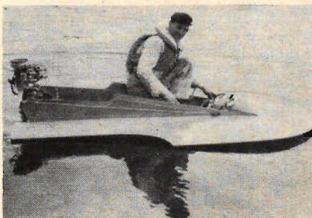
Motorn skiljer sig som synes väsentligt från den kompakta version, som levereros till vanligt båtfolk. Observera de två specialtillverkade avgasrören t.v. och racerns specialförgasare t.h.
