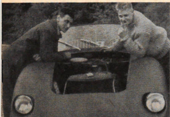
Motorerna i de båda plastsportbilarna är på 68 hk. Efter trimningen beräknar "bygggherrarna" utvinna ca 98 "håstar". Med ett överväxelaggregat hoppas de på en toppfart uppåt 200 km/tim.
