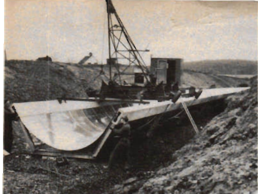
En flottningsränna av lättmetall är det senaste på lättmetallfronten. Rännan, som är hela 6 km lång, har monterats vid Stornorrfors kraftverk och består av 983 element, som fogas samman med maskinell hjälp. Vattenfall, Skultunaverken och Asea bygger.
