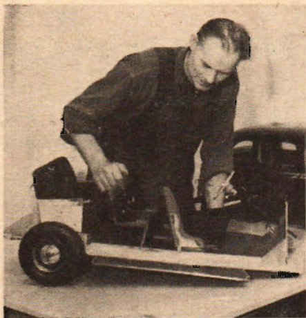
Här demonstrerar Gustav Christersson chassi och inredning till PV 444-modellen. På chassit monteras sedan karossen, som urholkats ur allrä så noga att sidornas tjocklek är bara några få mm.
