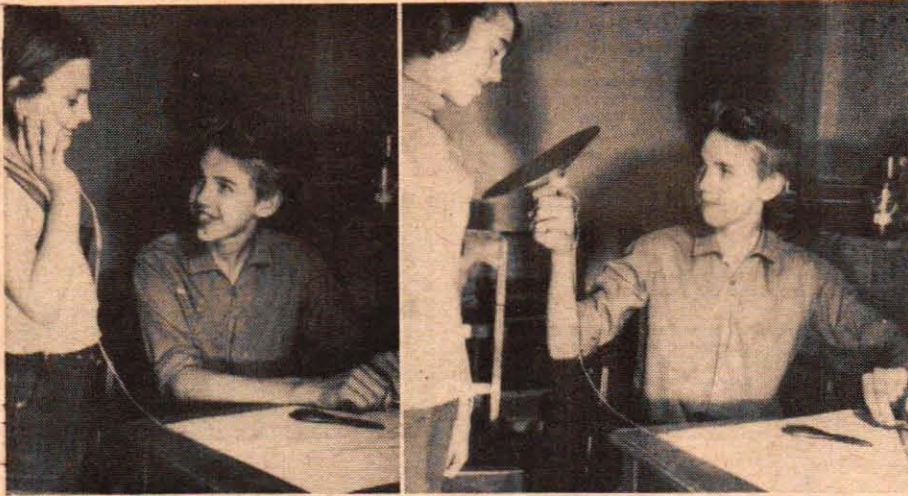
Den talande tvålasken, som provas ovan t. v. väcker både förvåning och beundran. Ovan t. h. provas "världens enklaste högtalare", samma enkla spole som i tvålasken men försedd med en kon av papper.
