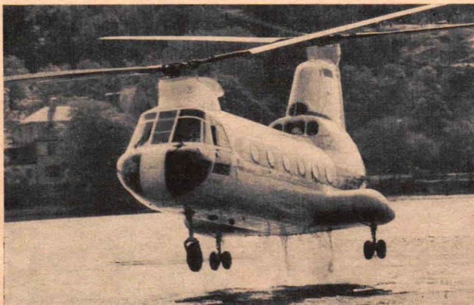
Vertol 107 landar lika bra på vatten som land. Den är konstruerad som amfibie och tål 1,5 m höga vågor. Amfibieegenskaperna har uppnåtts utan att flygkroppen behövt utformas som båtskrov. Då det inte finns risk för att någon rotor skall slå i vattnet kan därför låga sättningshastigheter användas.
