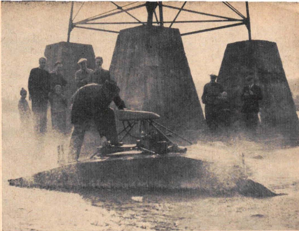
Detta är den första bilden av ett "lyft" med en "luftkudde"-farkost. Bilden togs i mitten av 1930-talet, då civilingenjör T. Kaario gjorde de första lyckade försöken att få en farkost att sväva på en kudde av luft. Den engelska "flygande dammsugaren" Hovercraft bygger på exakt samma idé.
