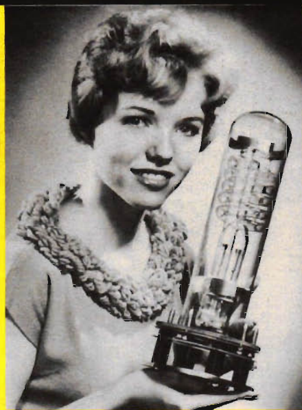
Världens starkaste lampa presenteras av flickan på bilden. Lampan ger 25 miljoner normalljus och användes bl. a. för nattlig flygfotografering.
