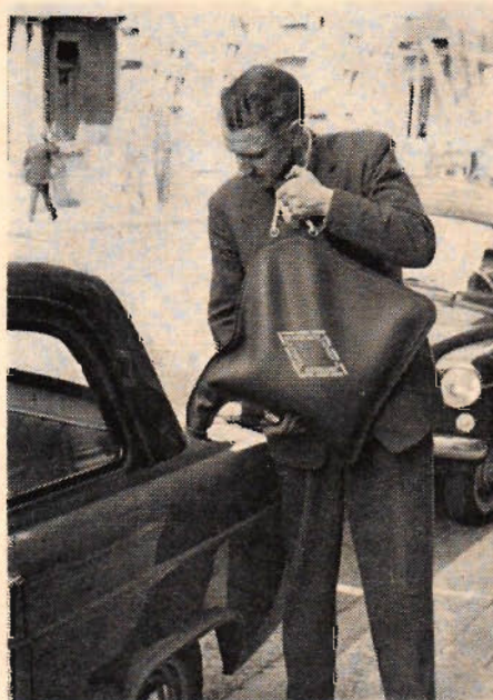
En reservdunk, som inte skramlar eller skaver, tar liten plats i bagagerummet och ändå rymmer tillräckligt med bränsle, har hittills mest varit en önskedröm. Nu är den förverkligad, och mannen på bilden visar hur. Den nya "dunken" är tillverkad av nylon och viks ihop, när den är tom.
