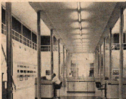
Bilden ovan visar sändarsalen vid Radio Neder-lands sändarstation i Lopik, Holland. I denna finns tre 100 kW, två 50 kW och en 10 kW-sändare. Radio Nederland kan höras i Europa på 6 020 kp/s.
