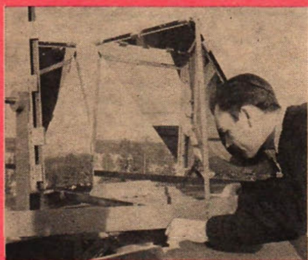
Lekmannen skulle knappast kalla apparaten ovan för en kamera. Men fil. mag. Georg Gustafsson, som byggt apparaten, är nöjd med sin "norrskens-kamera", ett av de få exemplaren i världen.
