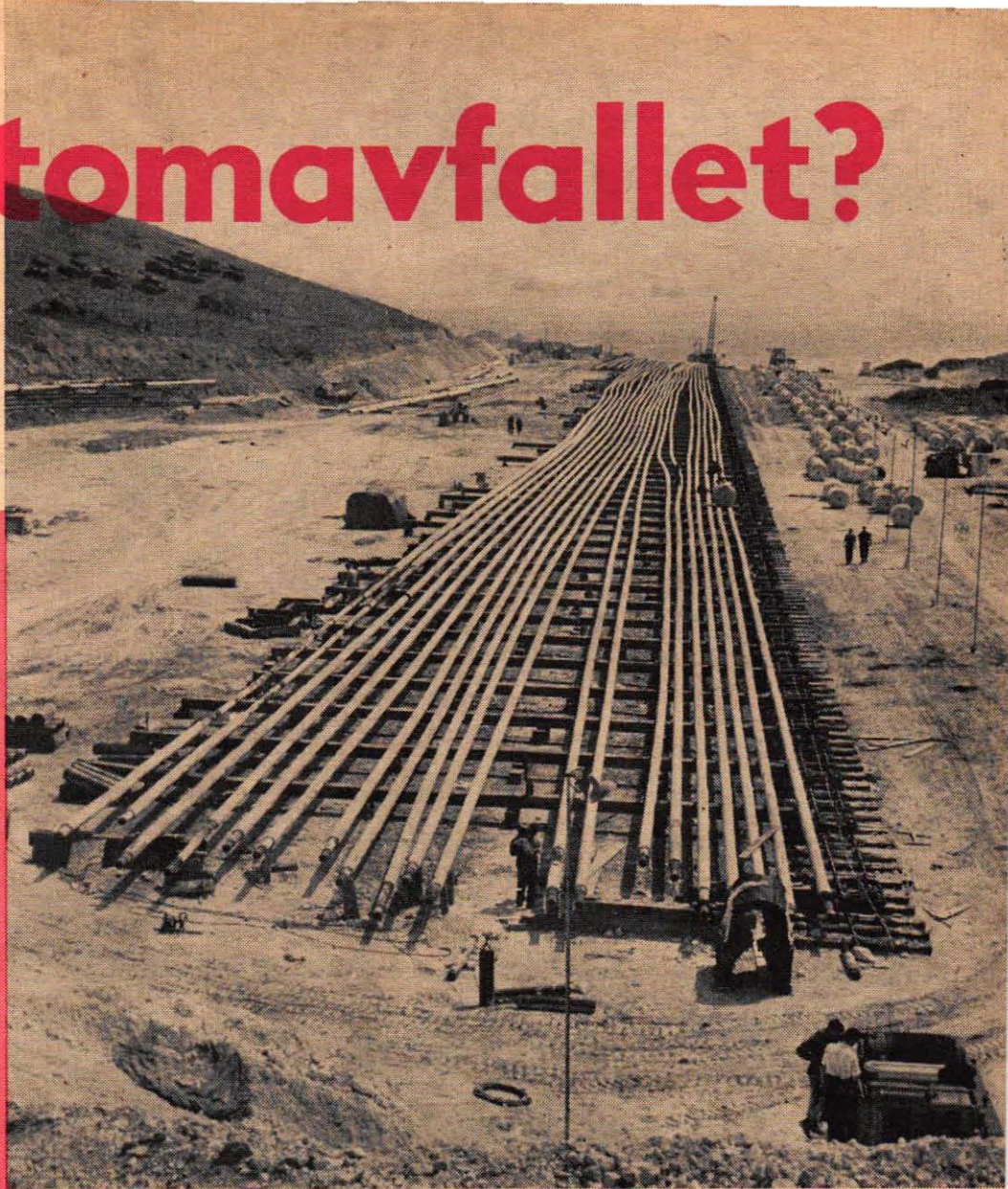
En nio kilometer lång rörledning har byggts för att föra det flytande radioaktiva avfallet från atomlaboratoriet i Winfrith Heath i England. Ledningen mynnar ut i havet ungefär fyra kilometer från kusten.
